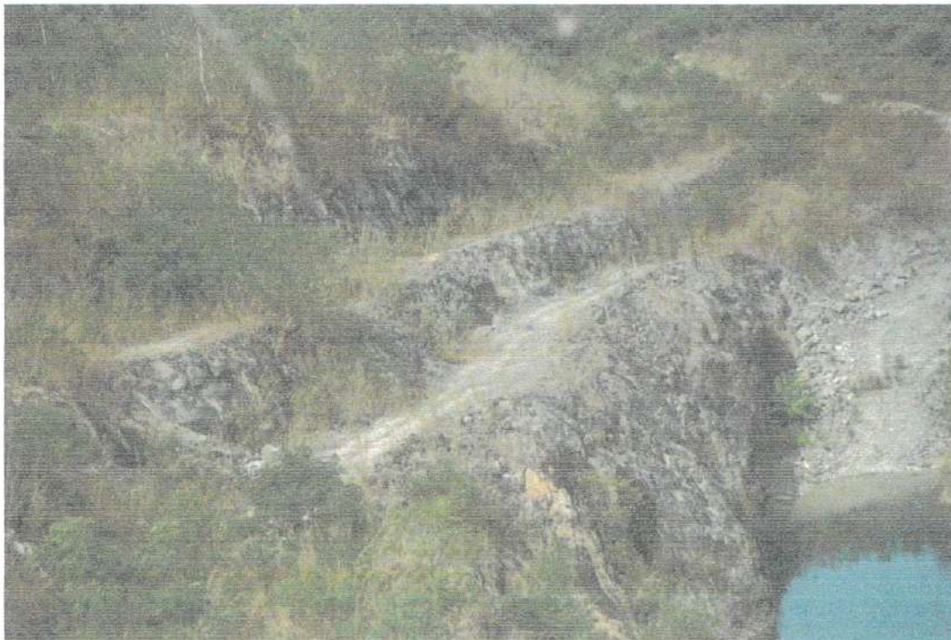
รูปที่ 6 ผนังชั้นบันไดบริเวณทิศตะวันตกของบ่อเหมืองไม่เกิดการโป่งพอง ต้นไม้ปกคลุมเกือบทั้งหมด
